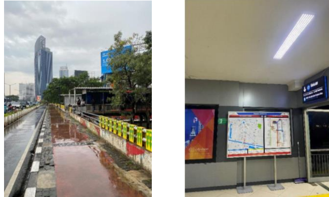
Gambar 8. Fasilitas Kanopi & Wayfinding di Segmen KRL - TransJakarta
