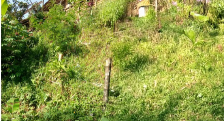
Gambar 30. Kondisi lereng dengan proteksi metode bamboo cribwall pada bulan Mei 2021.
