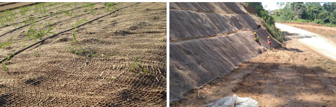
Gambar 24. Penerapan cocomesh pada teknik hydroseeding di IKN [Ardiasa, 2024].
