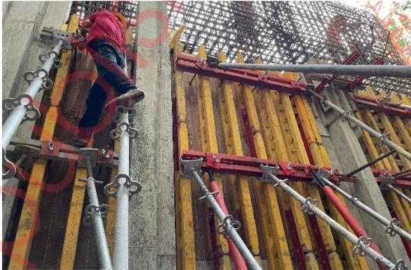
Gambar 23 Pemasangan Bekisting
