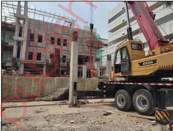
Gambar 16 Penggunaan *Mobile Crane* Kapasitas 25 Ton
