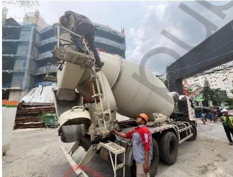
Gambar 30 Pemberian Zat Aditif untuk Mengontrol Suhu
