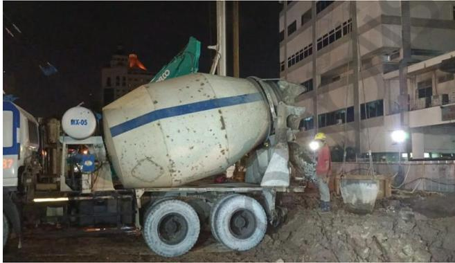
Gambar 21 Pengecoran Fondasi *Bored Pile*
