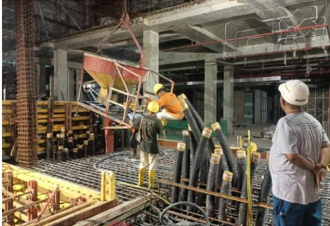
Gambar 24 Pengecoran HDC
