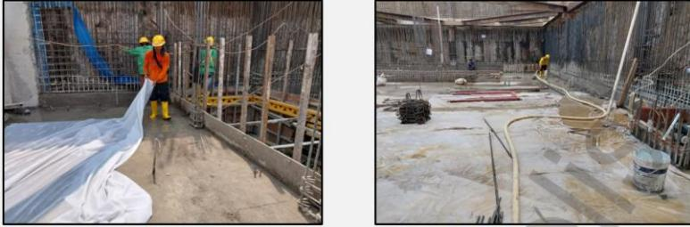
Gambar 52 *Curing* dengan Geotekstil non Woven
