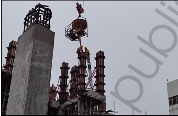
Gambar 48 Pengecoran Menggunakan *Bucket Cor*
