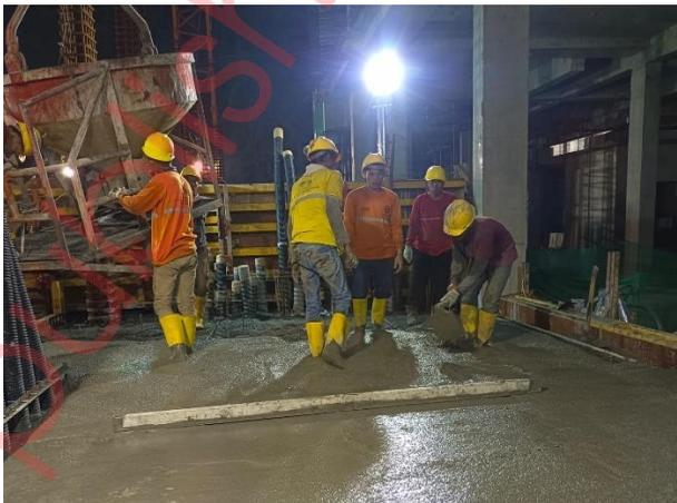
Gambar 26 Pengecoran dan Perataan Beton
