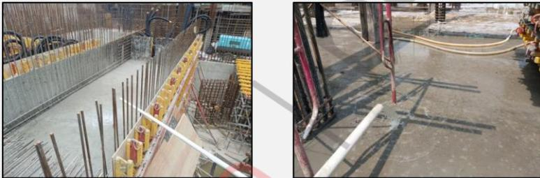
Gambar 51 *Curing* dengan Penyiraman Air
