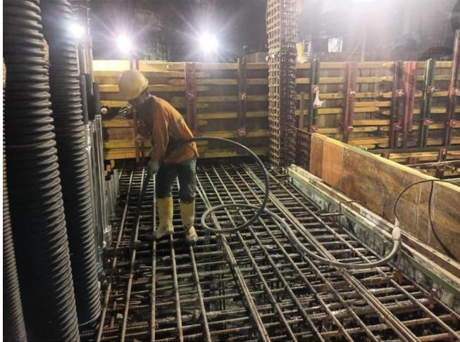
Gambar 28 Pengecoran dan Pematatan Beton
