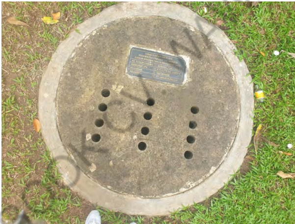
Gambar 41. Lubang Resapan Biopori yang dibangun Dinas Sumber Daya Air, Pemerintah Provinsi DKI Jakarta
