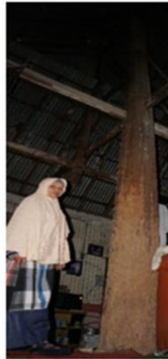
Gambar III.7 Ukuran Satu Hasta Tangan Ibu dari Rumah Gadang sebagai Standar Satuan Ukuran (Modul)
