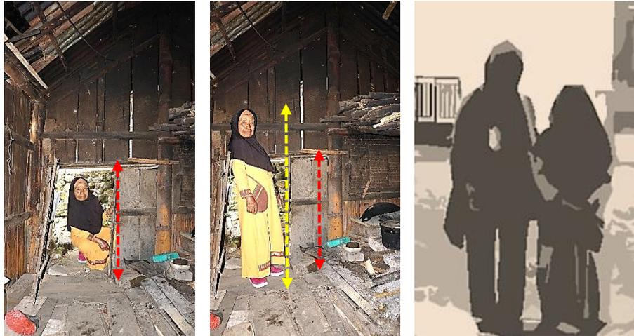
Gambar IV.26 Kiri dan tengah: Tinggi pintu dapur disesuaikan dengan tinggi pengguna. Kanan: Perbandingan tinggi pengguna dan peneliti.
