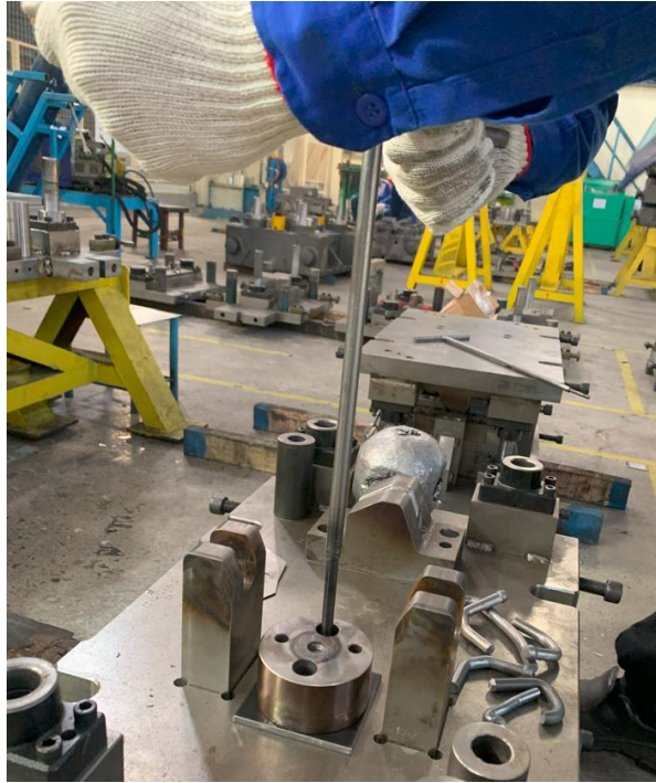
Gambar 4.8 Proses Pemasangan Insert Upsetting Pada Upper Dies
