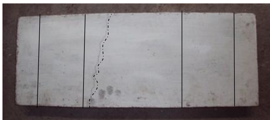
Gambar 5.17. Pola retak panel dinding BPSL3_300
