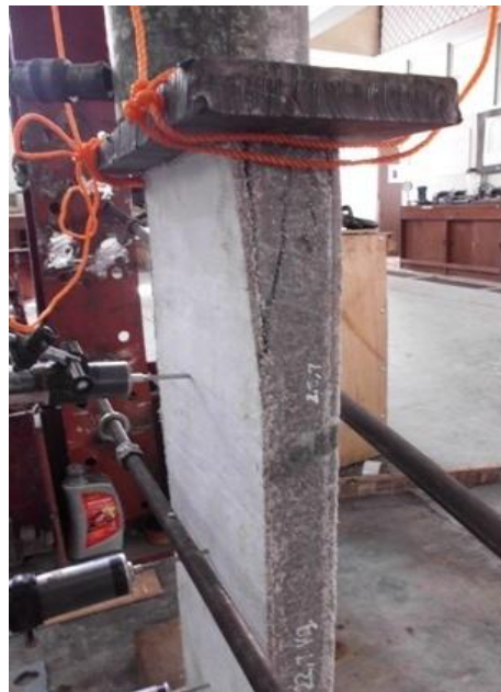
Gambar 5.29. Tipe kerusakan akibat uji tekan panel dinding polystyrene PST1_300
