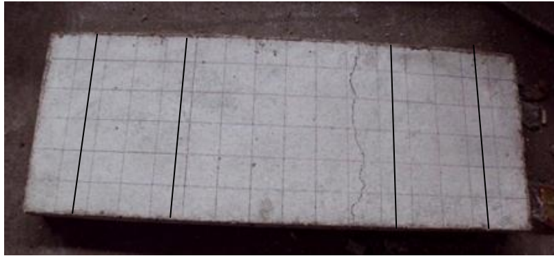
Gambar 5.11. Pola retak panel dinding BPSL3_250
