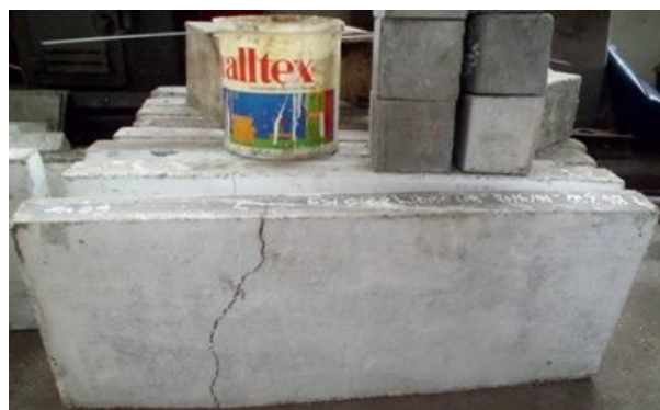
Gambar 5.40. Pola keruntuhan benda uji panel dinding polystyrene
