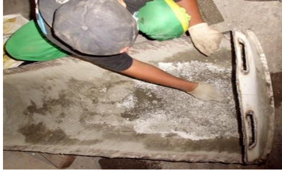
(a) Pengadukan balok beton polystyrene
